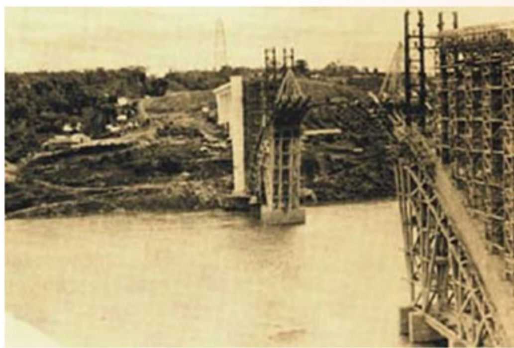
Construção da Ponte da Amizade
